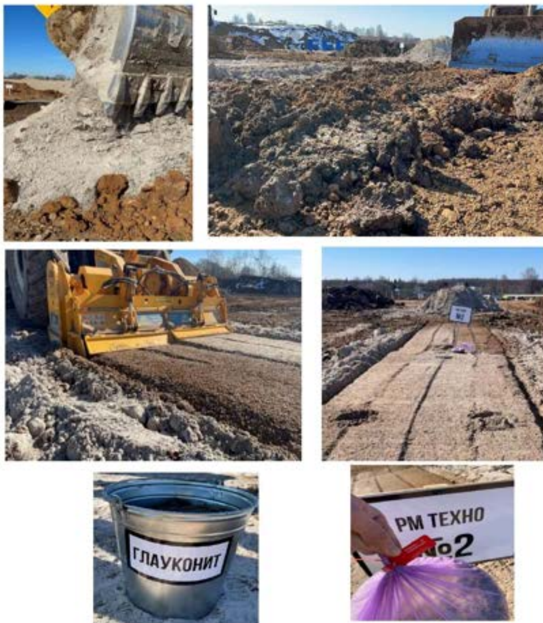
Рис. 17 – процесс изготовления рекультиванта минерального марки «PM-Техно №2»
