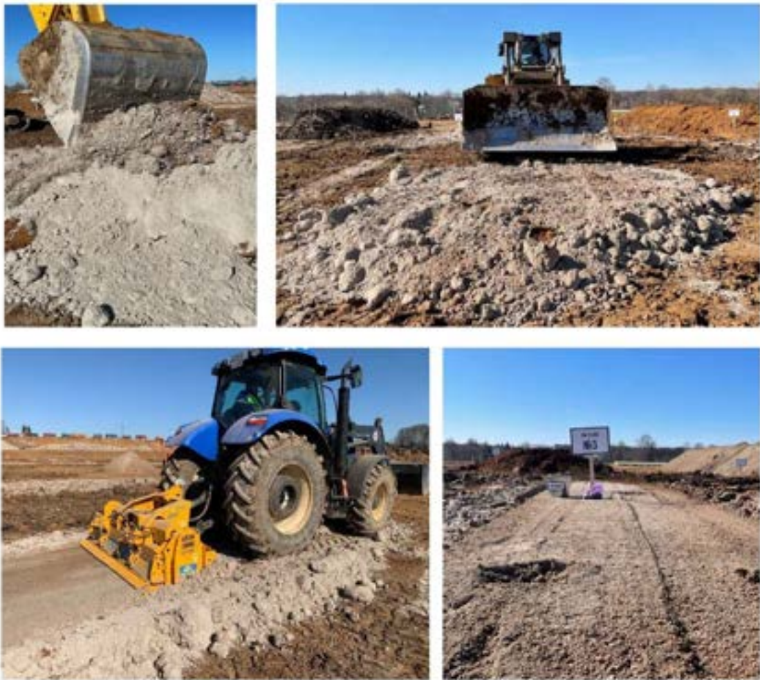
Рис. 18 – процесс изготовления рекультиванта минерального марки «РМ-Техно № 3»
