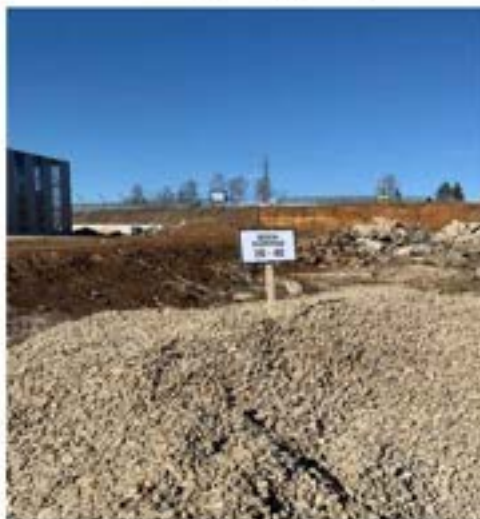
Рис. 8 – щебень вторичный с размерами фракций 20-40 и 40-80 мм
