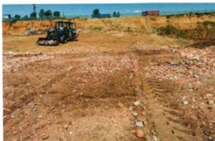
Рис. 11 – процесс изготовления рекультиванта минерального «РМ-Техно» вторым способом.
