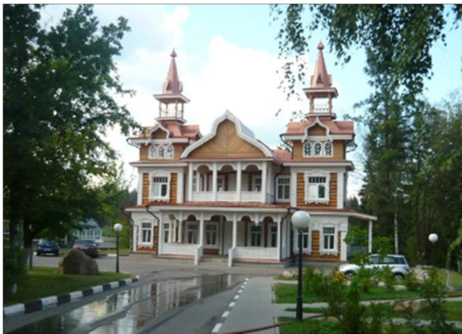
Фото. Дача Проскуряковых (воссозданный объект культурного наследия)
