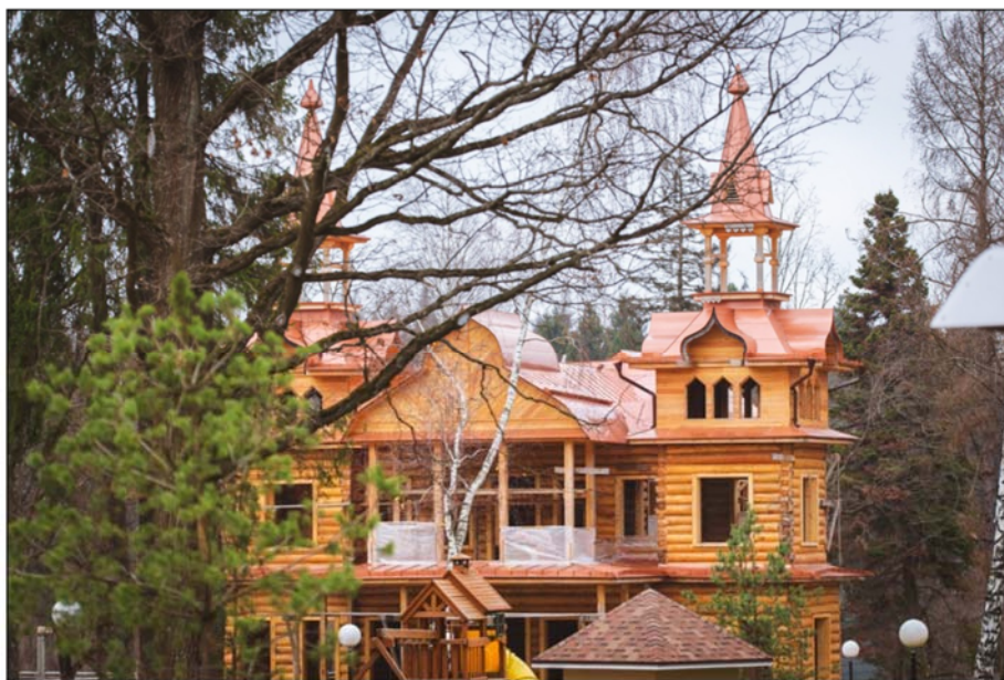
Фото. Работы по воссозданию дачи Проскуряковых, 2013 год.
