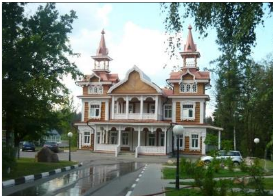
Фото. Дача Проскуряковых (воссозданный объект культурного наследия)
